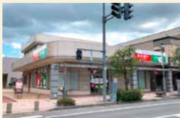
【弘前地区】（弘前市大字土手町211-1）
