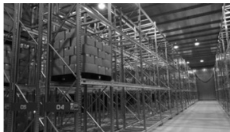
自動保管冷凍庫（内部）
