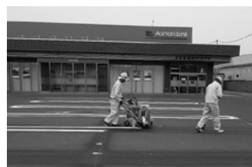
松原通り支店での施工（2021年5月）
