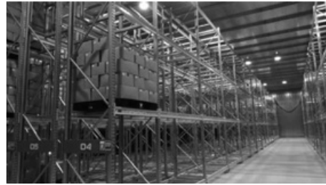
自動保管冷凍庫（内部）
