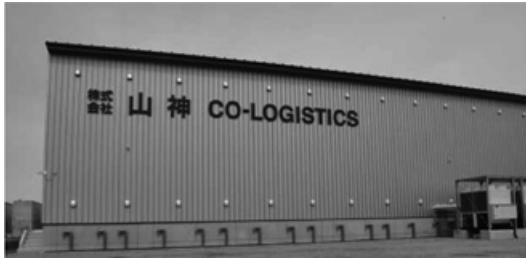
自動保管冷凍庫（外観）
